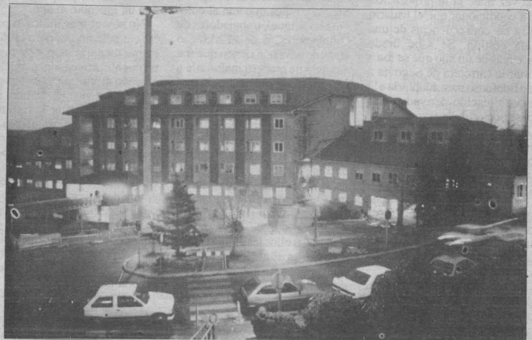
El Hospital General, al atardecer, poco tiempo después de recuperar el suministro eléctrico.
