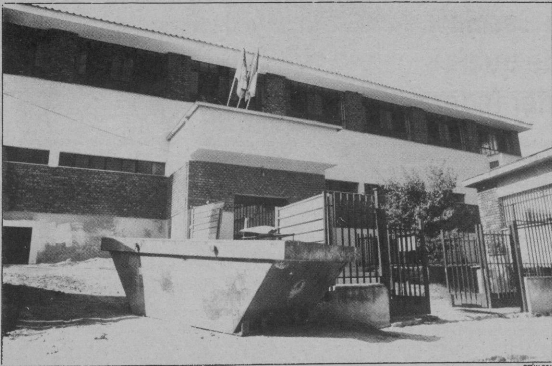
Obras en el "Emperador Teodosio".
