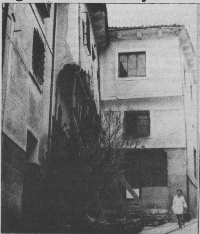
Fachada y entrada principal del colegio apuntalado
