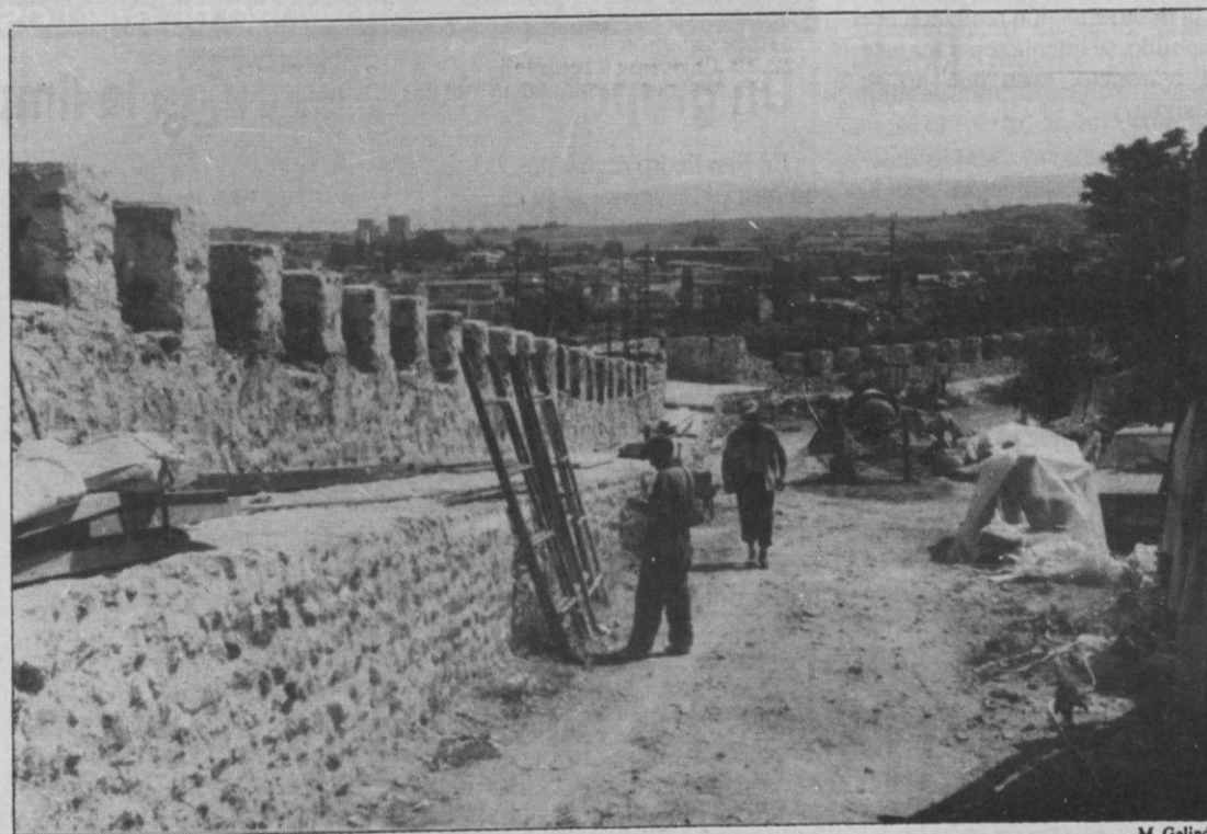
Los trabajos de consolidación de la muralla se llevan a buen ritmo
