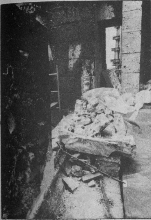
A la izquierda, estado de una balastrada totalmente deteriorada. En la otra imagen, parte de un barandal ya reconstruido a base de un entramado de hilos de bronce y morteros
