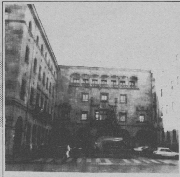
DELEGACION DE SALAMANCA En rehabilitación
