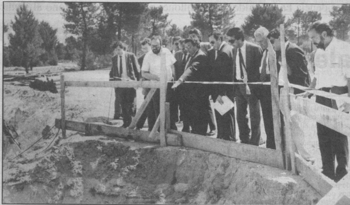
Parlamentarios regionales visitan las obras del parque tecnológico.
