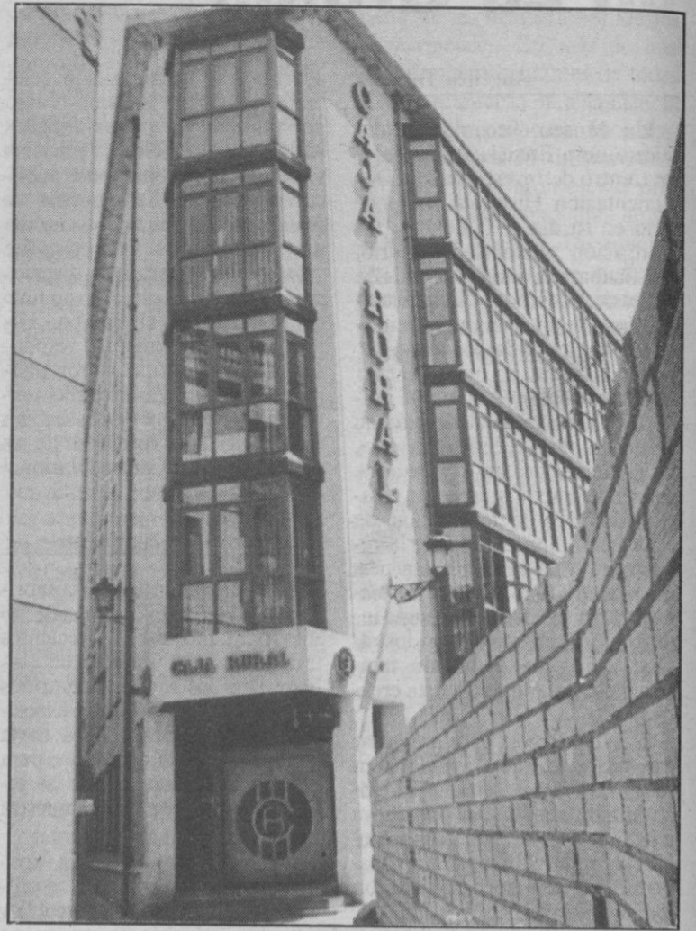
Sede de la Caja Rural de Soria. Foto: FERNANDO SANTIAGO
