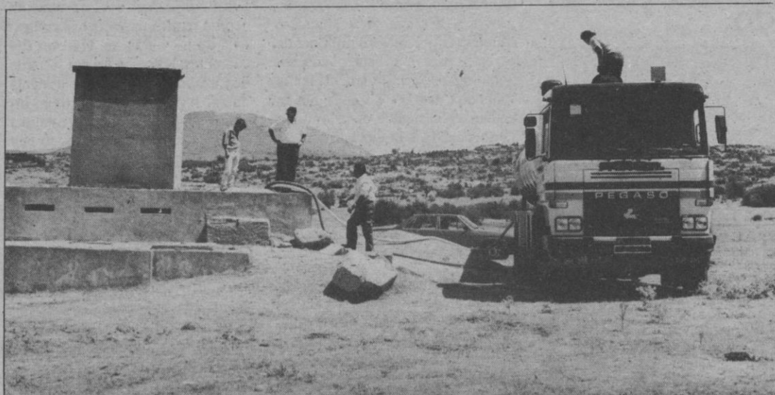
Una imagen ya clásica en muchos pueblos: camiones cisterna surtiendo de agua a los depósitos
