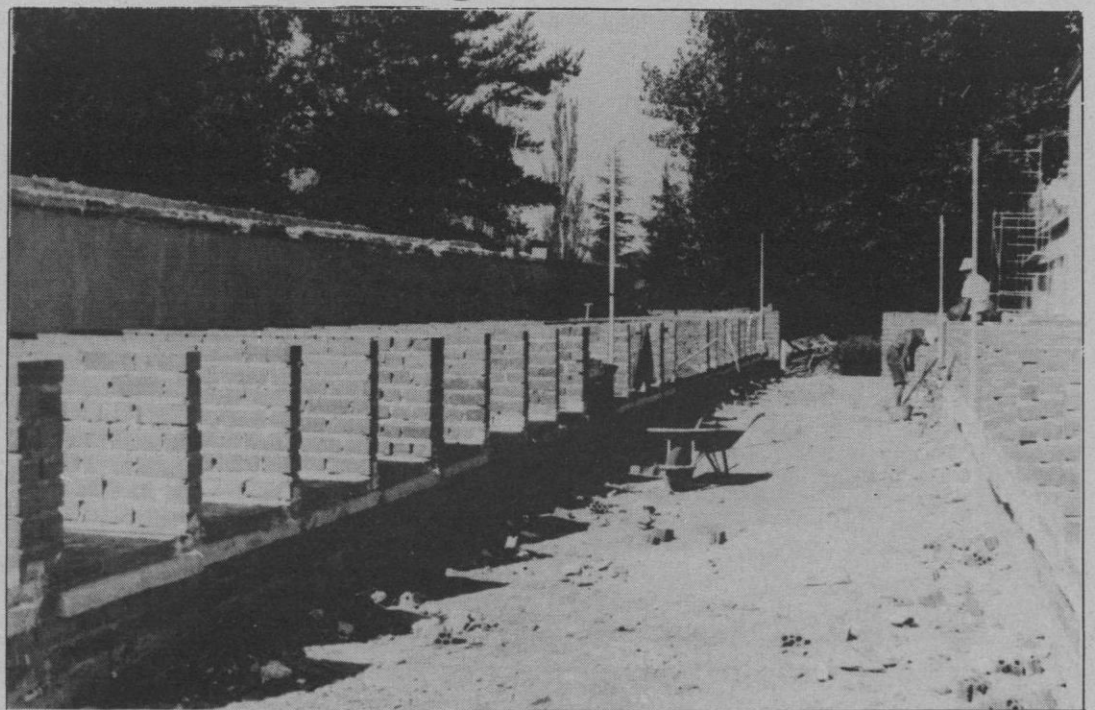
Construcción de nuevos nichos en el cementerio
