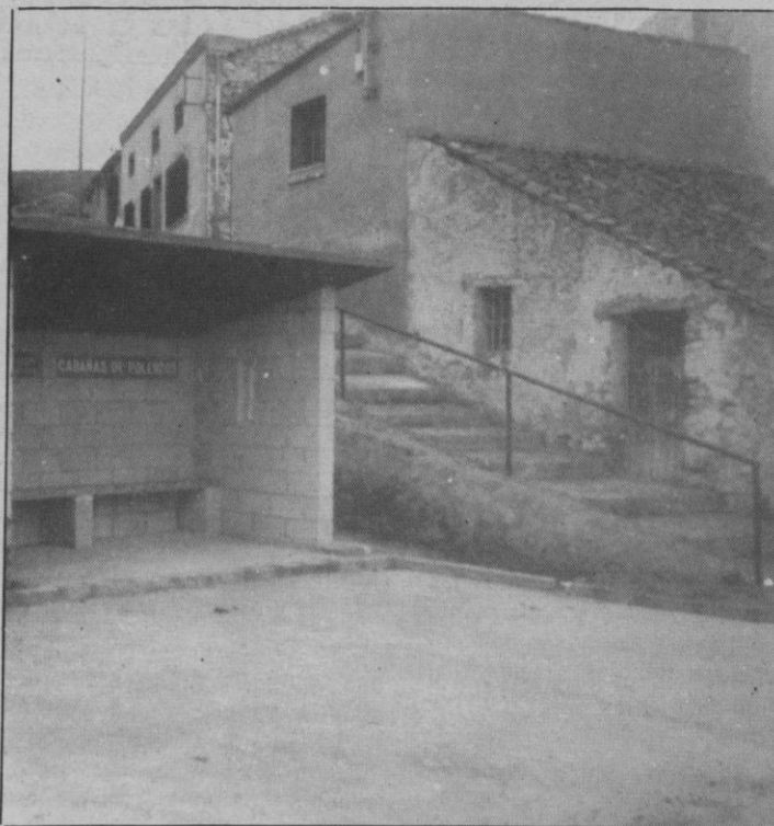
El refugio y las escaleras de acceso
