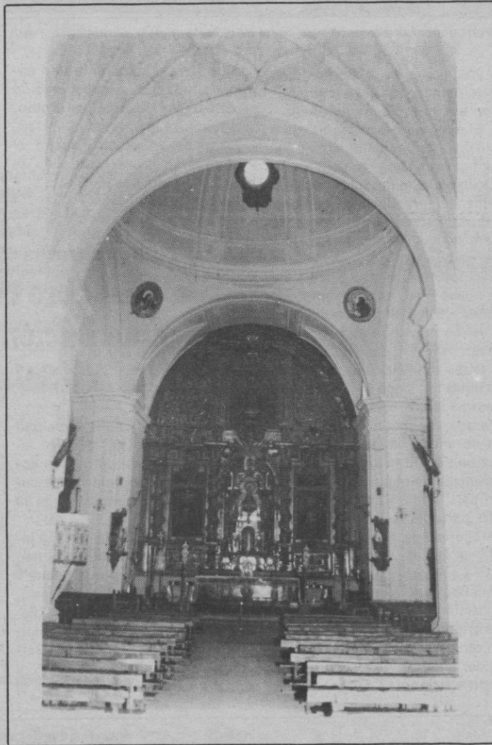
Final de la nave y crucero
