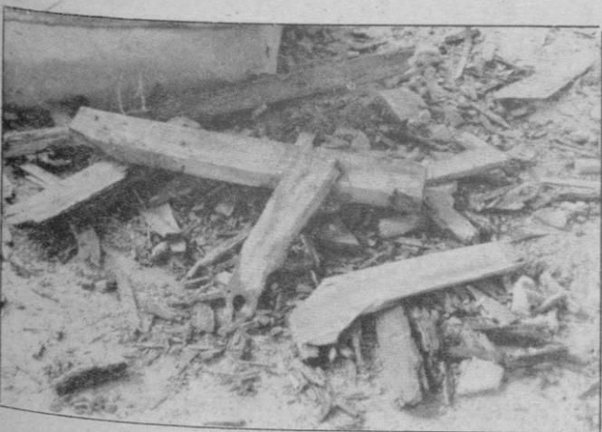
El deterioro de la madera del techo produce derrumbes de consideración
