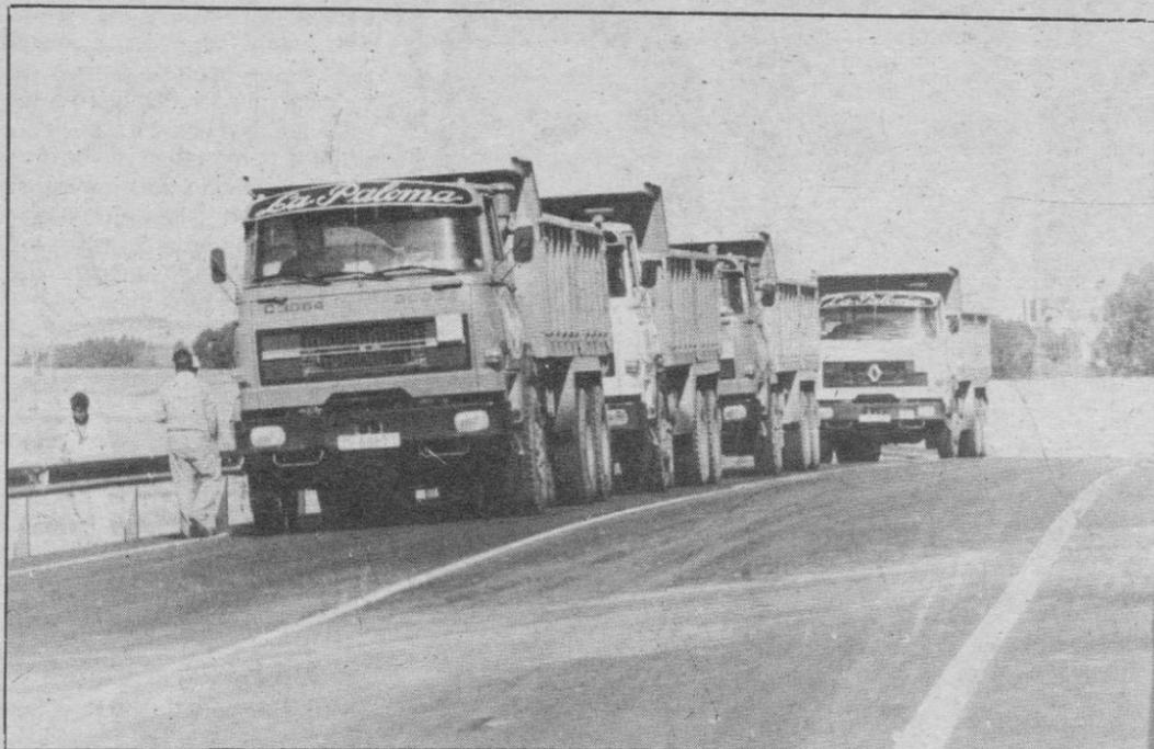
Se ha realizado ya la prueba de carga en el puente construido sobre la línea del ferrocarril de Segovia a Medina del Campo, en el punto kilométrico 8/761, para la supresión del antiguo paso a
