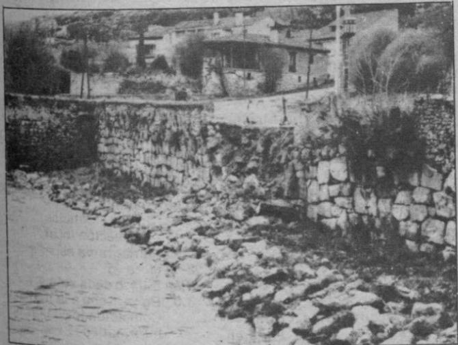
terio, ha provocado el derrumbamiento de buena parte del pretil. El nivel de las aguas, a escasamente 20 centímetros de la alameda y de las huertas de la otra orilla, nos hace preguntarnos qué hubiese ocurrido si no se hubiera procedido al dragado del río a su paso por este lugar.
