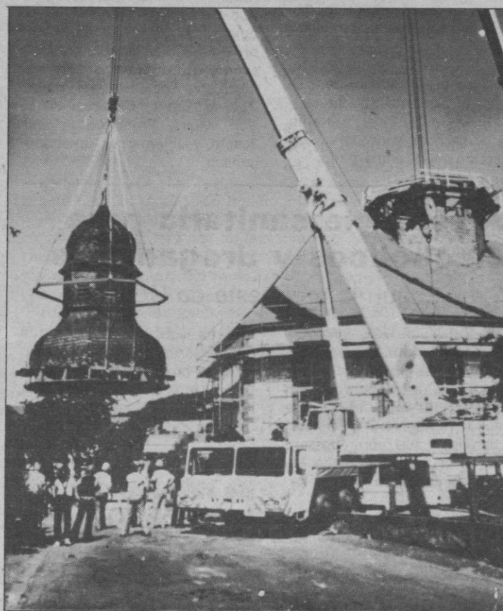
En la fotografía se recoge el momento en que mediante una grúa especial se procede a izar
