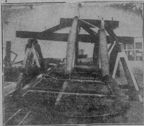
Guadalajara. — Un nuevo modelo de avión construido en una fábrica de é-ta. Durante la prueba el avión resistió una carga en arena superior a trece veces al mayor esfuerzo que deberá exigirsele en el aire.
