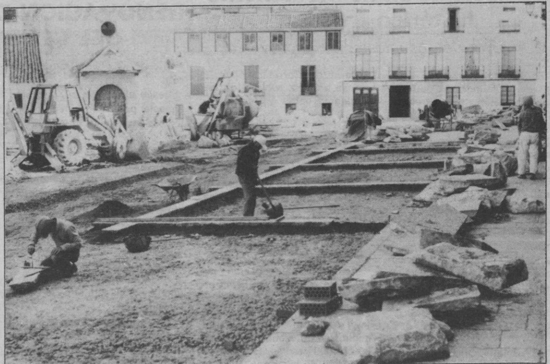
Las obras de la plaza de San Esteban.
