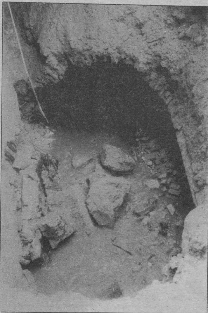
En el Polígono de San Millán en uno de sus patios donde están ubicadas unas aulas prefabricadas se produjo este socavón que dejó prácticamente en el aire a una de las aulas. El socavón lo provocó el río Clamores que pasa por debajo
