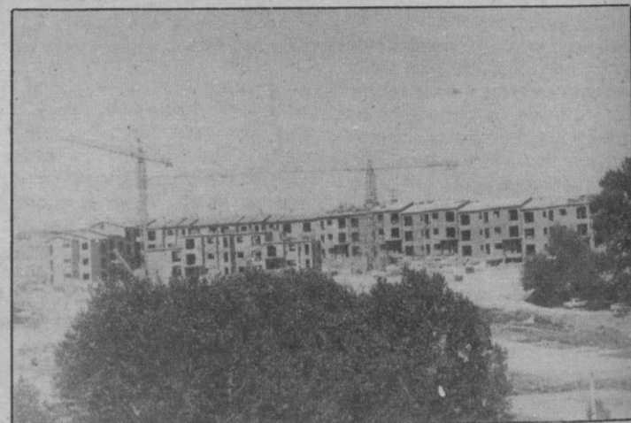
Vista panorámica de las 100 viviendas que construye el MOPU.
