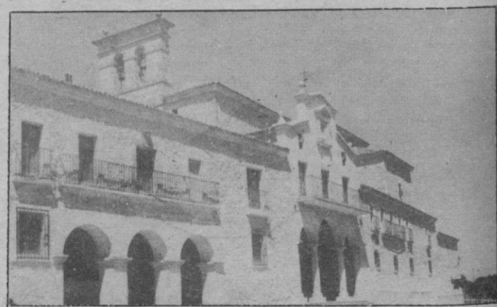
Fachada principal del Santuario del Henar, reconstruida por el MOPU.
