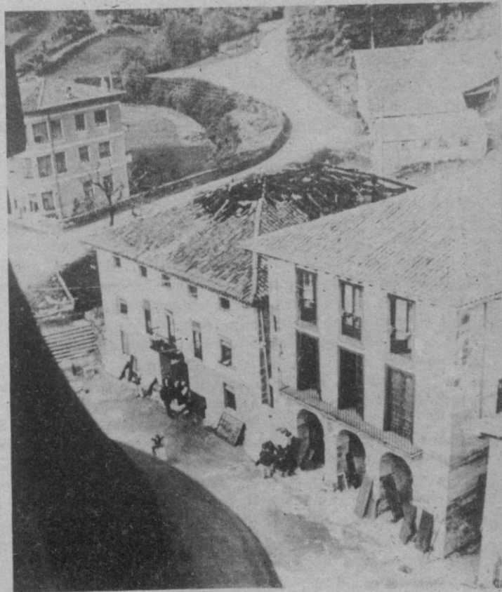
La Puebla de Bolívar (Vizcaya).— La casa «Jáuregui», de los antepasados de Simón Bolívar, libertador suramericano, ha quedado destruida a consecuencia de un incendio. Las paredes del edificio resistieron el siniestro, pero el fuego destruyó prácticamente la totalidad del inmueble, y la techumbre. La casa solariega de Bolívar es de gran valor histórico. (Telefoto Efe)
