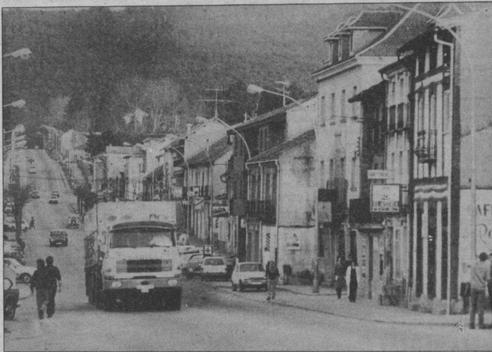
Ayer, en el cine de San Rafael, durante cuatro horas se celebró una reunión para tratar sobre el proyecto de acondicionamiento de la travesía por dicha localidad, de la N-VI Madrid-La Coruña, travesía que aparece en la fotografía de Aurelio M.
