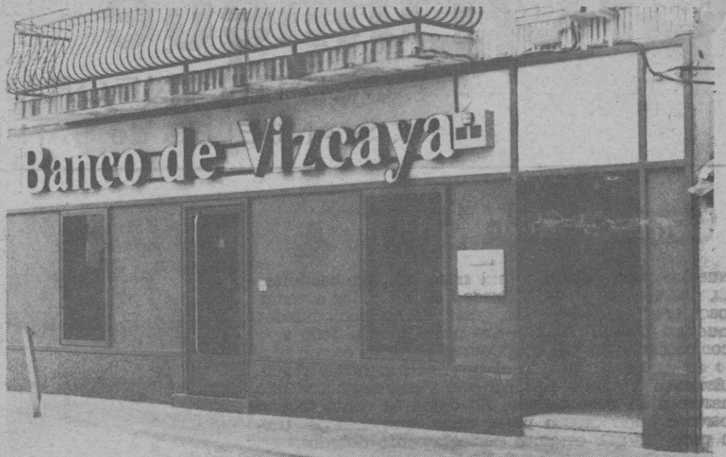
Fachada de la nueva sucursal del Banco de Vizcaya en Villaverde de Iscar
