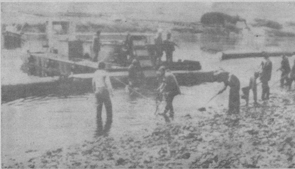
Los Establecimientos Generales de Mecánica del Oeste (EGMO), de Francia, han construido una máquina de descontaminación utilizable para la limpieza de la superficie del agua. «Egmolap» es un recuperador que «lapa» la superficie del agua y aspira los productos contaminadores más diversos, especialmente los hidrocarburos.
