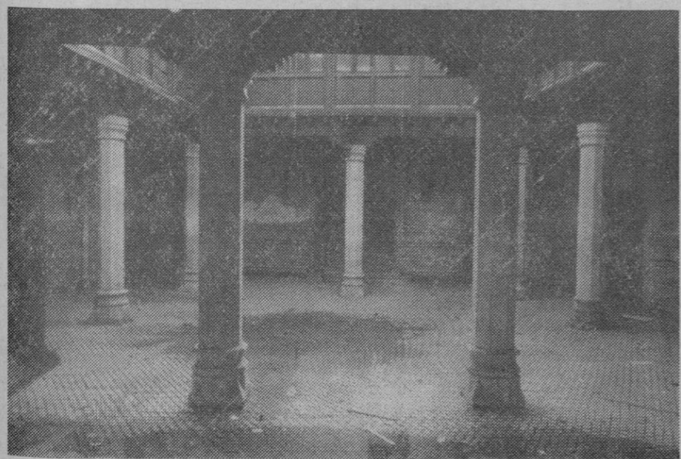
Aspecto interior de la "Casa de los Picos". Poco a poco el descuido va produciendo daños en el edificio. La puesta en marcha de la Escuela de Artes Aplicadas y Oficios Artísticos vendría a significar la revitalización en el uso de tal singular edificio y su recuperación para el patrimonio segoviano
