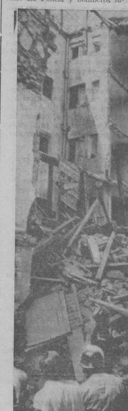
Madrid no sólo se hunde por abajo—es decir, en su calzada—sino también por arriba, en la techumbre de sus casas. He aquí una muestra. El edificio se vino abajo afortunadamente sin víctimas.
