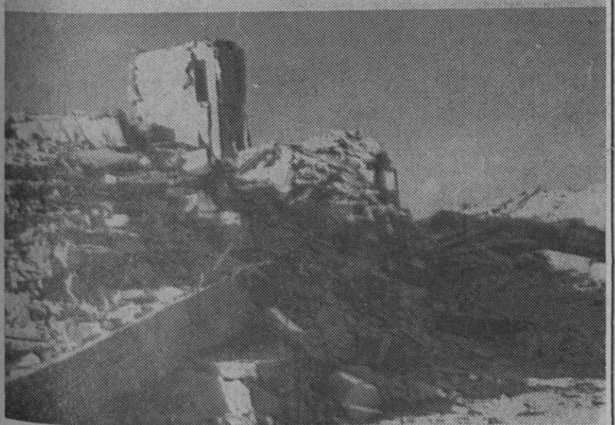
Ibiza.—El hotel «Insula Augusta», construido sin prevenir las dificultades al tráfico aéreo del aeropuerto de Ibiza, ha sido demolido en la mañana de ayer. En la foto, el «antes» y el «ahora» del Insula Augusta. (Foto Europa Press.)
