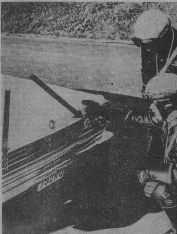
Lieja (Bélgica).—Unos policías belgas comprobando en un coche un dispositivo ideado por unos inventores de Bélgica para denunciar el exceso de velocidad. El dispositivo puede ser instalado en los coches y consta de cuatro puntos luminosos, dos de ellos en la parte delantera del vehículo. Al pasar de los sesenta kilómetros de velocidad se enciende una de las lámparas, las dos si se llega a los cien kilómetros.—(Foto Europa Press)
