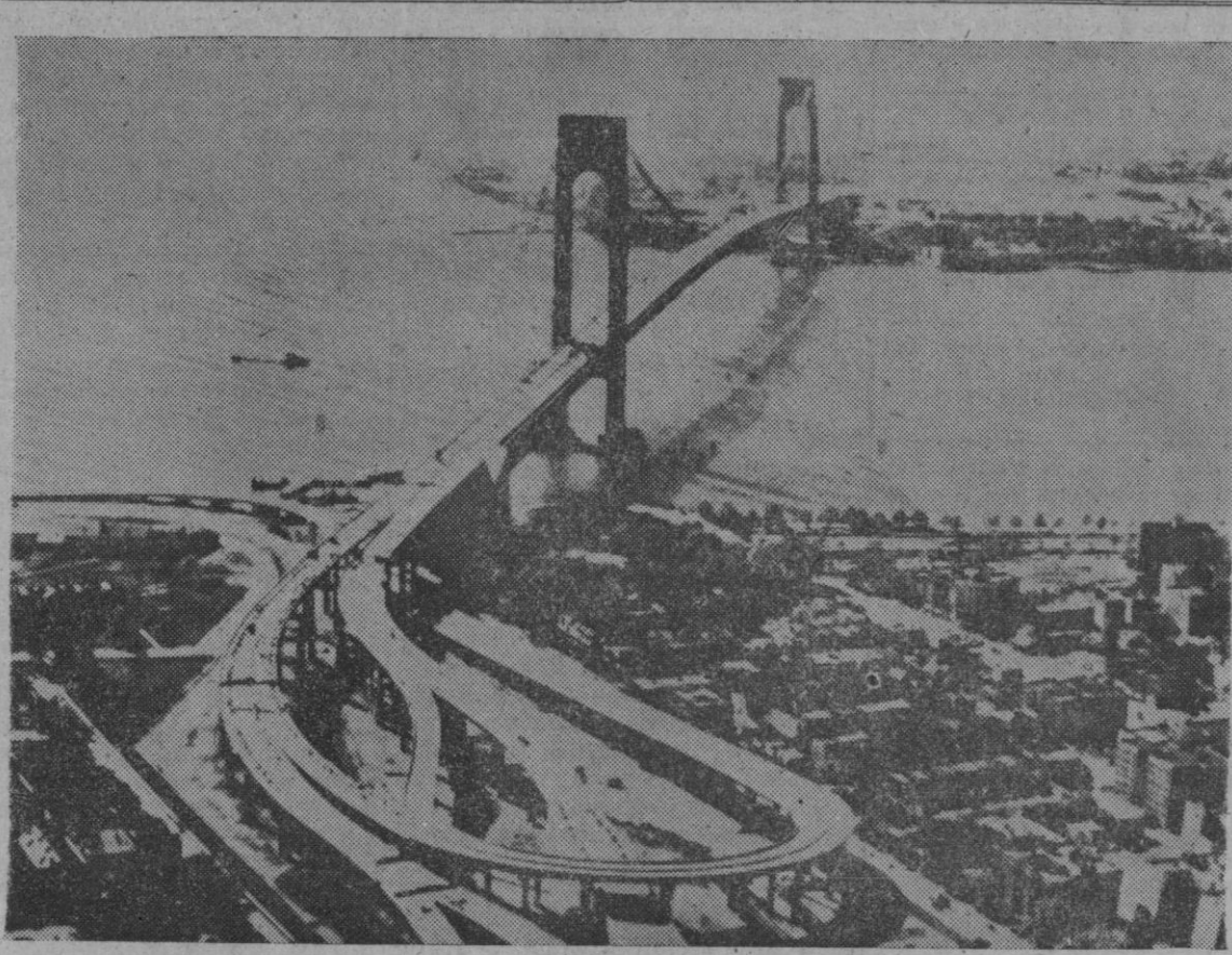
Vista general del puente de Verrazano (Nueva York), que une Brooklyn con Staten Island y que acaba de ser inaugurado. Es el más costoso (325 millones de dólares, 19.500 millones de pesetas), el más largo y el más moderno del mundo, de un solo tramo. Se calcula que lo atravesarán anualmente 150 millones de vehículos. Su altura permite el paso bajo él de barcos como el "Queen Mary", el mayor trasatlántico del mundo.—(Foto Fiel)
