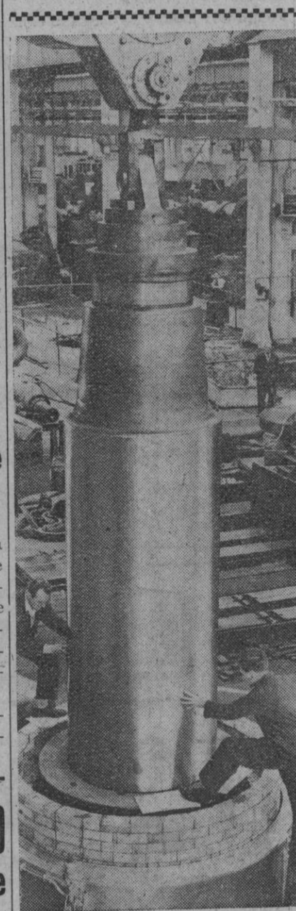
Los dos mayores cilindros de acero forjado hasta ahora fabricados por una acería de Sheffield—cuyo peso es de cincuenta y siete toneladas cada uno—, son transportados al tren de laminación en caliente de Ferbratil, Bélgica. En esta fotografía se ve cómo penetra el alma en uno de ellos en su manguito; que se ha ensanchado por calor.
