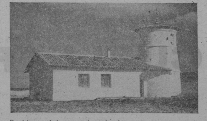
Depósito regulador y transformador de energía eléctrica, para la recolección e impulso de las aguas
