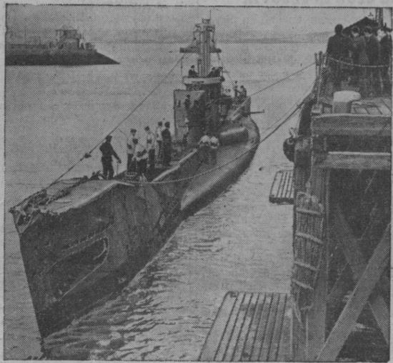
Este submarino que aparece ante ustedes, ha permanecido un mes en el Océano Glaciar Ártico, estando sumergido durante todo ese tiempo, lo que ha podido llevar a cabo gracias a un aparato que le permite usar sus motores de combustión interna para la propulsión y que servía para renovar el aire respirable.
