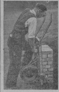
He aqui un nuevo modelo de carretilla, que sirve exclusivamente para transportar ladrillos. Los ladrillos es preciso que estén colocados especialmente y con sólo apretar una palanca carga-rán cuarenta cada vez sin más
