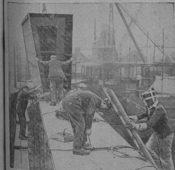
Obreros ingleses armando el costado de un barco prefabricado en los astilleros de Hull
