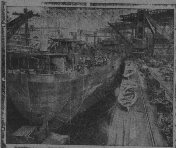
Vista de un astillero británico en donde se construyen barcos prefabricados. Los motores y máquinas (a la derecha) preparados para ser instalados en el buque que aparece en la foto
