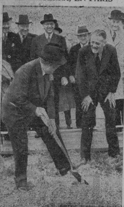
Kingsley Wood, ministro del Aire de Inglaterra, saca la primera palada de tierra en los terrenos de Birmingham, donde va a ser construída una gran fábrica de aviones costeada por lord Nuffield, que aparece junto al ministro
