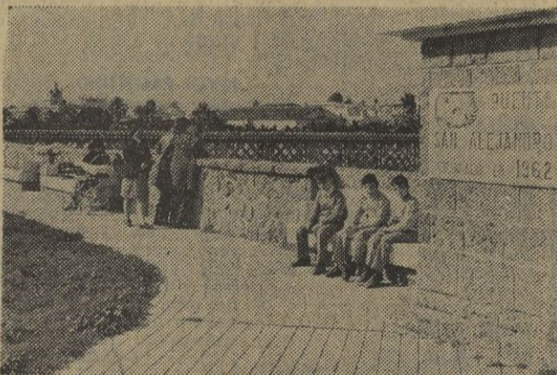
Puente de San Alejandro, junto a la carretera general Madrid-Cádiz. Tras darle un golpe de karate, tiró a Francisco Marín por el pretil.
