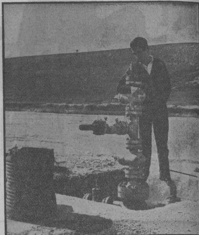
«Ayoluengo 2». Se cerró en espera de un nuevo equipo de sondeo. El tubo por el que «mira» nuestro enviado especial termina, abajo, en el petróleo...
