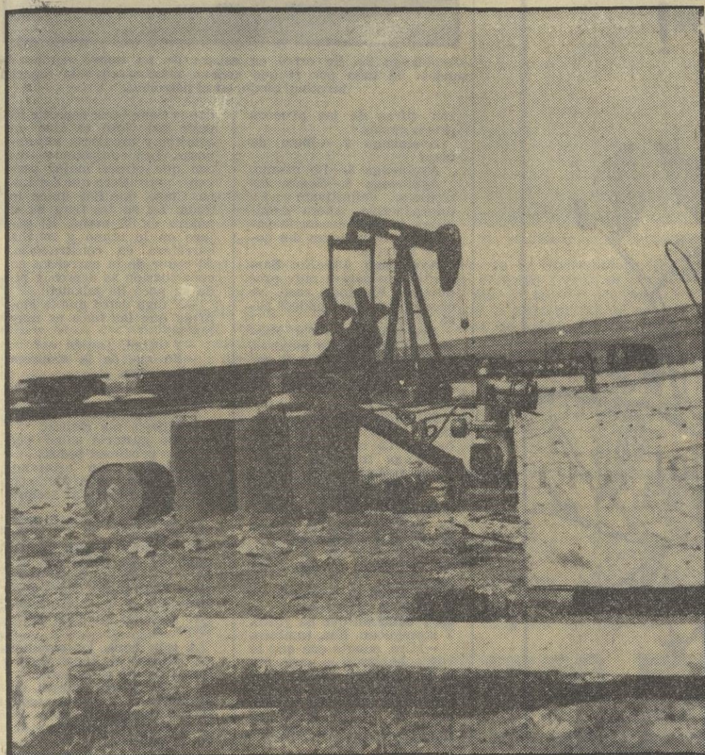
«Ayoluengo 1», el pozo vedette. Sólo de él se saca petróleo actualmente por medio de esta bomba de balancín llamada «cabeza de caballo articulado».
