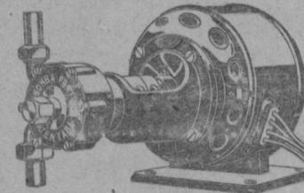
**Ideal** para usos domésticos. 500 litros de agua por hora a 40 metros altura. Acoplada a motores **monofásicos** de 174, 176 y 178 de HP. que puede conectarse a líneas ordinarias de luz.
