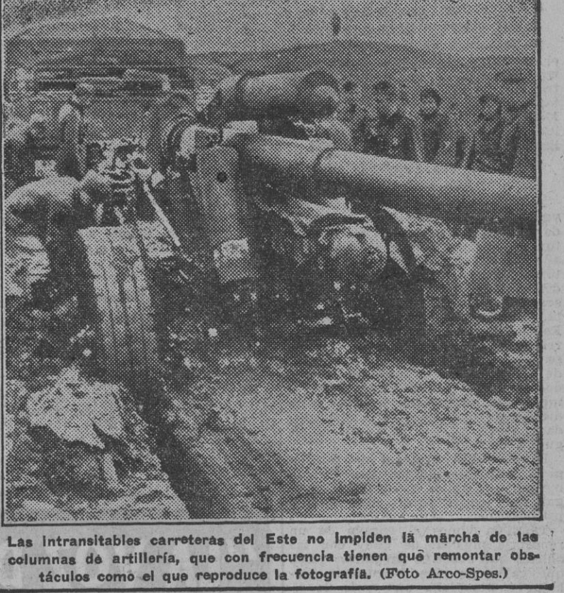
Las intransitables carreteras del Este no impiden la marcha de las columnas de artillería, que con frecuencia tienen que remontar obstáculos como el que reproduce la fotografía. (Foto Arco-Spex.)
