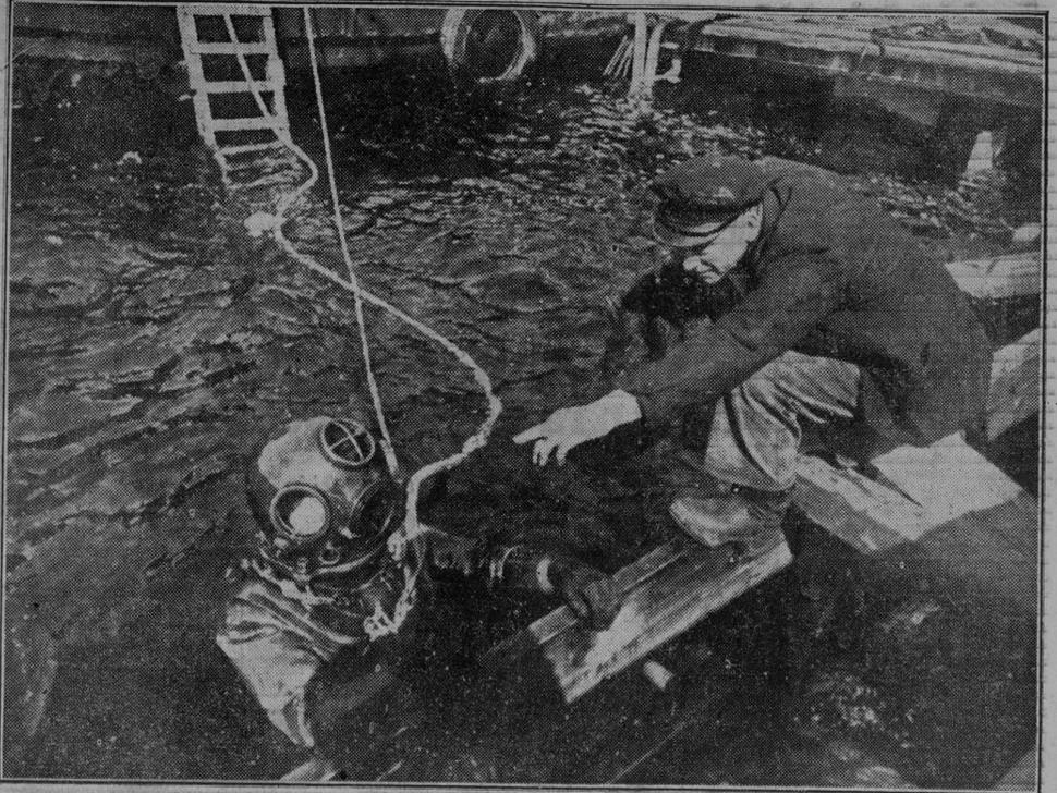
Los buzos trabajan constantemente en los puertos bombardeados. Después de localizar los buques echados a pique realizan las operaciones de achique, cierre hermético y encadenamiento especial para sacar a flote los cascos averiados. (Foto Orbis.)
