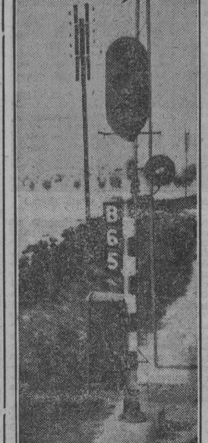
Una de las señales del "block" que acaba de prolongarse desde Villalba a El Escorial.
