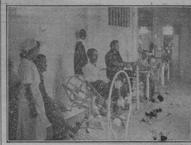
Aspecto parcial de la Sala de Mecanoterapia instalada en la Clínica del Trabajo.
