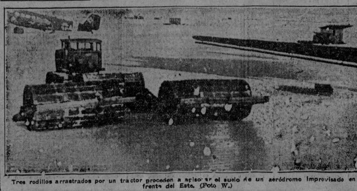
Tres rodillos arrastrados por un tractor proceden a aplastar el suelo de un aeródromo improvisado en el frente del Este. (Foto W.)
