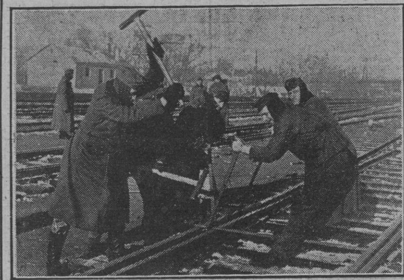
Equipos de trabajadores se dedican a renovar el tendido ferroviario de la zona ocupada soviética. Como se ve, se trabaja a ritmos rudos, igual que las españolas, de una anchura superior entre los dos carriles a las demás redes europeas.
