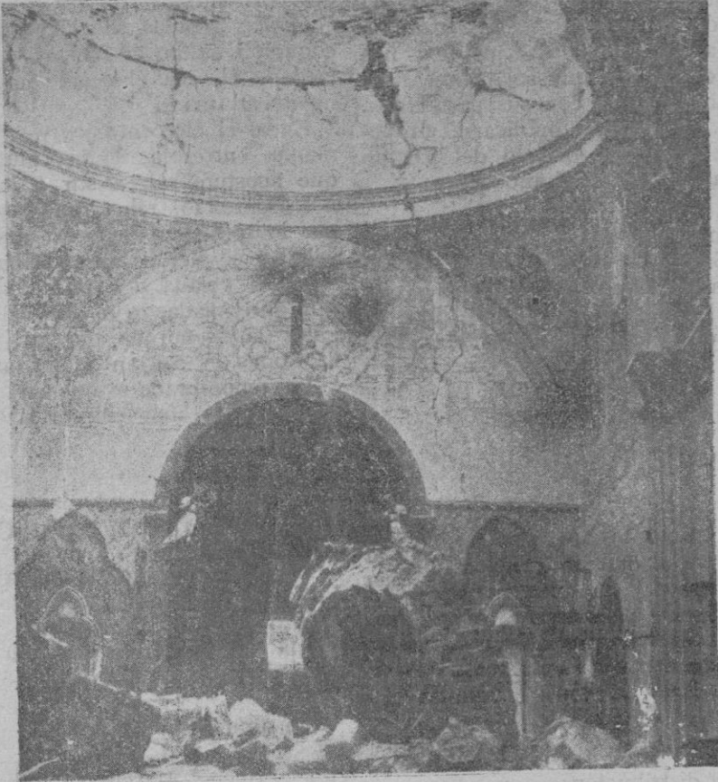
Estado a que quedó reducida la iglesia de Oaxaca, destruida a consecuencia del último terremoto y entre cuyas ruinas perecieron 51 de los fieles que en ella se hallaban congregados y el sacerdote que oficiaba al ocurrir el seísmo.
