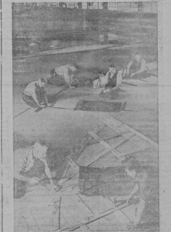
LA CONSTRUCCION NAVAL NORTEAMERICANA.—Con los planos al lado, los obreros trazan las líneas por donde han de cortarse las planchas de acero.
