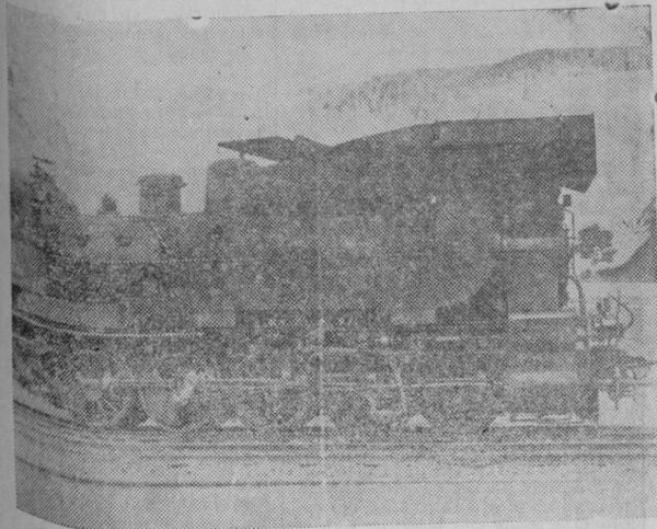
Aprovechando los gases calien es del humo y controlando el aire necesario para que ardan los carbones, se ha conseguido en Austria, aplicando a una locomotora el aparato que se ve en la foto, una economía de un 20 por ciento de carbón. (Express-Foto.)
