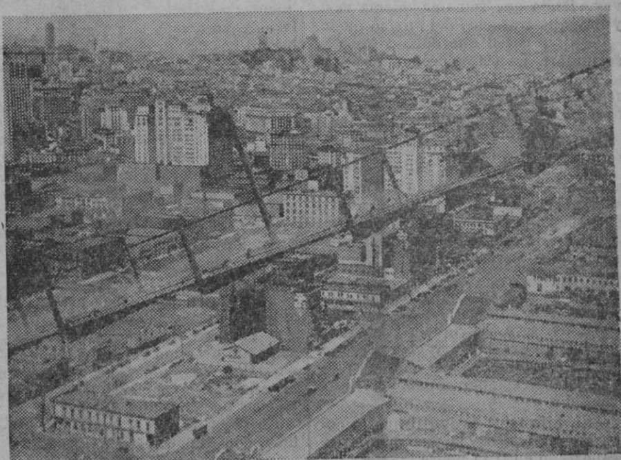
OBRREROS QUE NO TIENEN VERTIGO. — Les artistas de circo y varietés con sus saltos mortales, paso a la maroma, y todos sus ejercicios peligrosos no logran hacer temblar al público ni la mitad de estos obreros sobre los cables tendedores del Bay Bridge de San Francisco, el puente más grande del mundo terminan la construcción de este gigantesco trabajo. (Express Foto).
