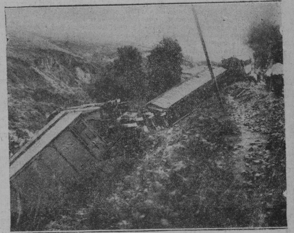
DESCARRILAMIENTO DEL EXPRESO DE GALICIA.—Situación en que quedaron los vagones de primera, volcados a la derecha de la vía
