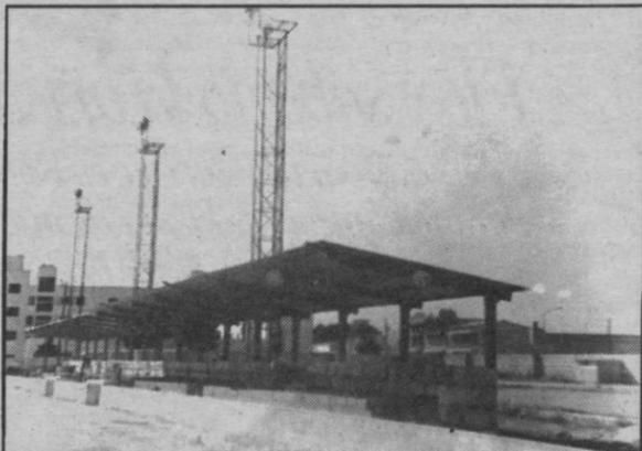
Ahora, se trabaja en la tribuna cubierta del lateral de sombra, ya que a la vez se construyen tres amplias gradas donde antes no existían y en la fijación de la armadura metálica que protegerá a los espectadores de las inclemencias del tiempo.
