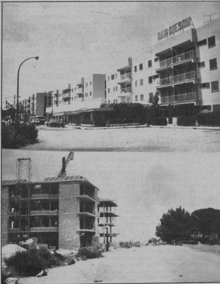
Viviendas sociales. Muy pronto, de mil habitantes se pasará a tres mil. Son Ferrer se está convirtiendo en un auténtico pueblo.
