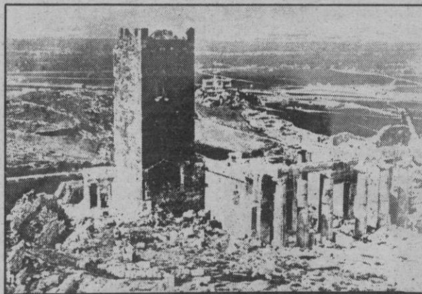
Antigua fotografía de la Acrópolis de Atenas, con una torre cuadrada, hoy demolida, cuya construcción es atribuida a los catalanes del siglo XIV. Cortesía de la profesora Irisa Maltésu.
